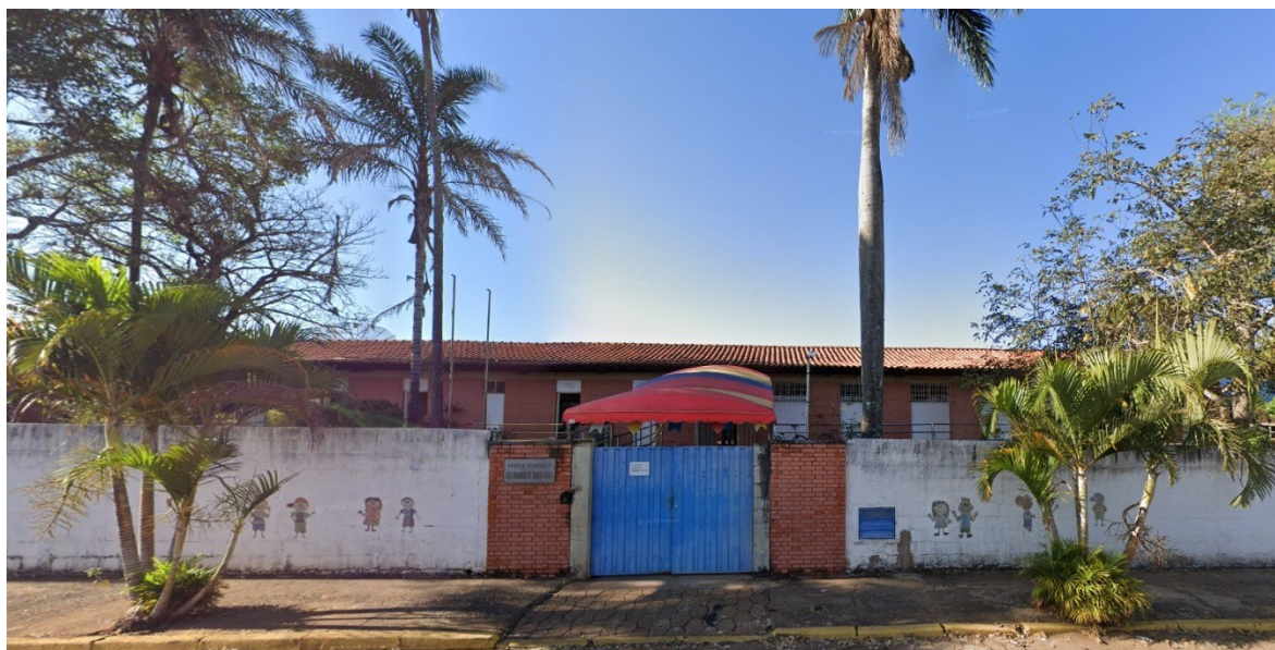
Figura 1 - Fachada Escola Municipal Coronel Cândido de Souza Dias
