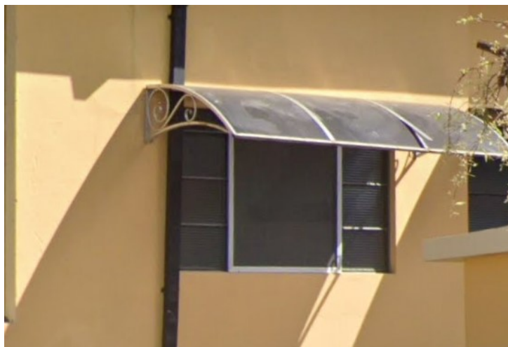
Figura 9 – Detalhe do modelo das estruturas dos toldos existentes (para as janelas)
