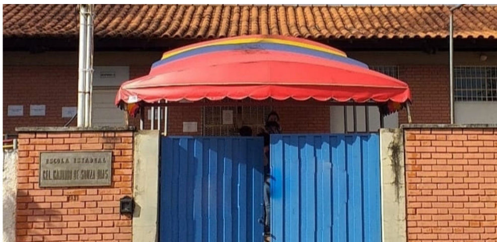
Figura 3 – Entrada principal da Escola Municipal Coronel Cândido de Souza Dias (local do toldo que deverá ser substituído pela cobertura de policarbonato)
