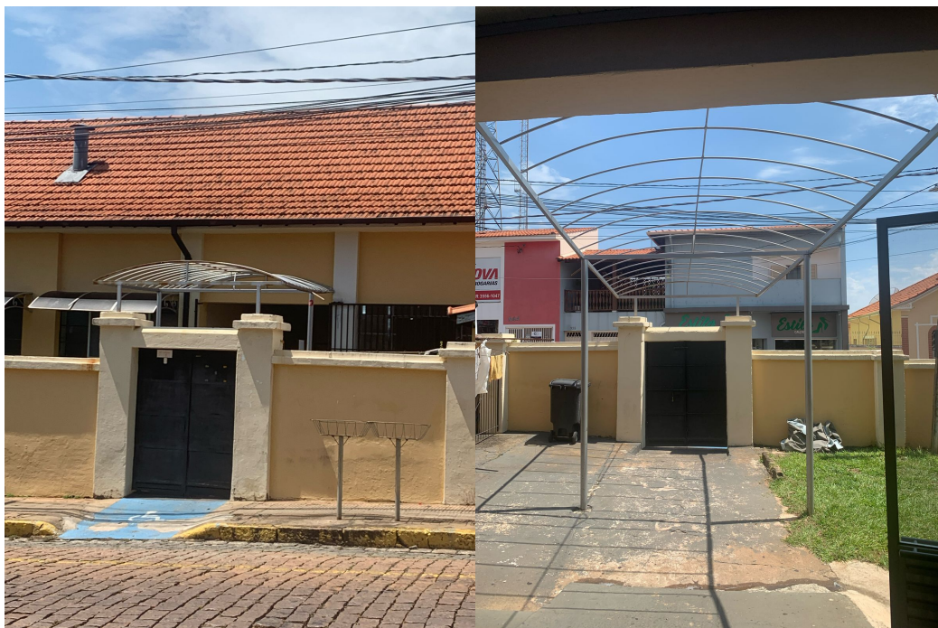
Figura 6 - Localização do toldo da entrada de acesso lateral do Colégio Arceburguense
