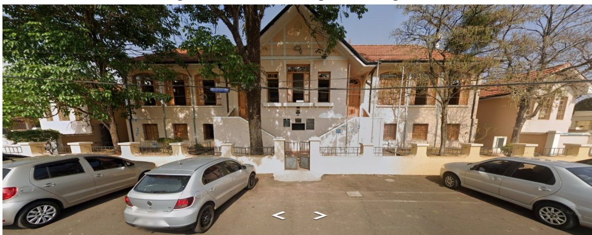
Figura 4 – Fachada Colégio Arceburguense
