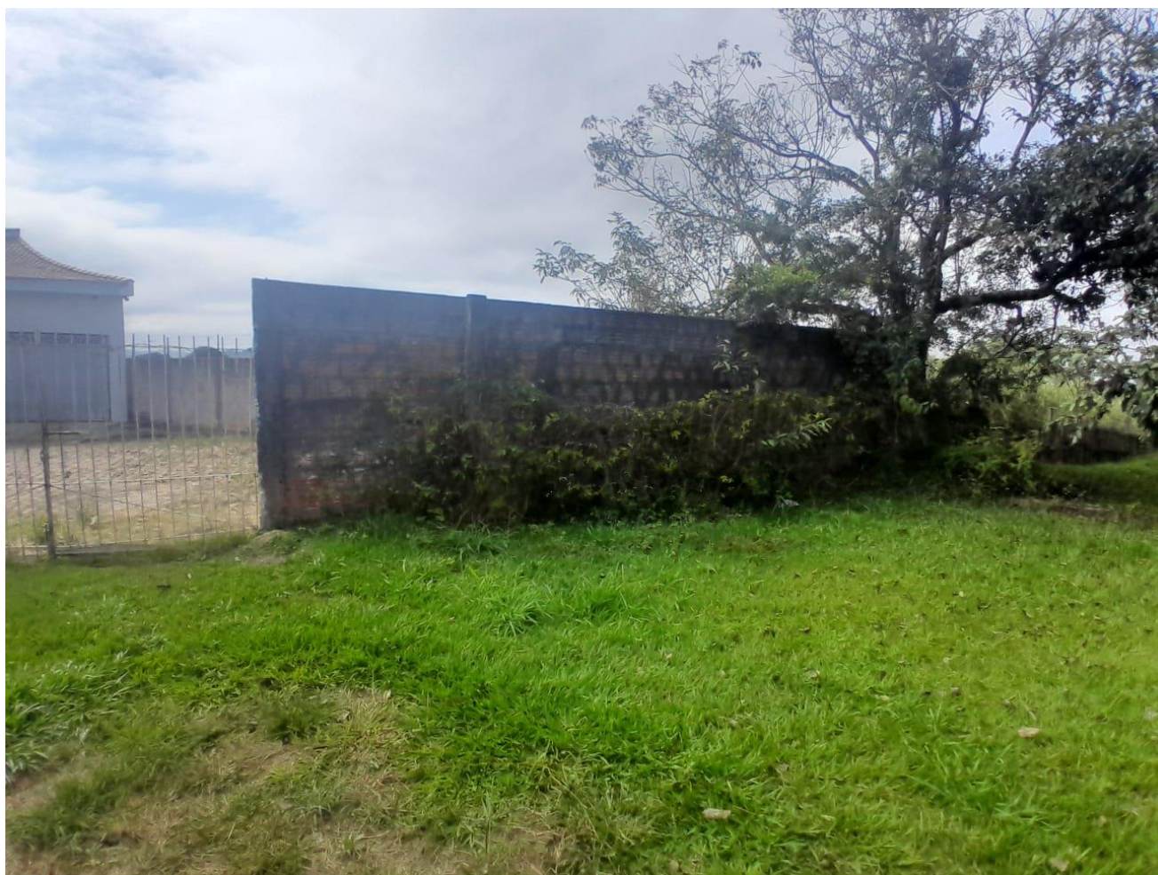
Figura 4 – Vista da área junto ao limite do terreno, evidenciando cobertura vegetal rasteira, muro de alvenaria, portão metálico de acesso e árvores de médio porte localizadas próximas à divisa.
