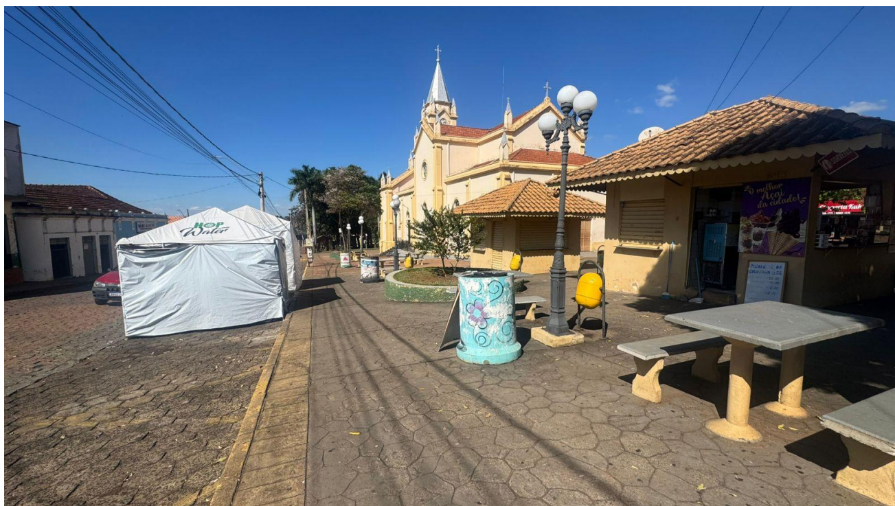
Figura 6 – Postes de iluminação existentes na praça, a serem contemplados com pintura e substituição das lâmpadas, visando à revitalização do sistema de iluminação do espaço público.
