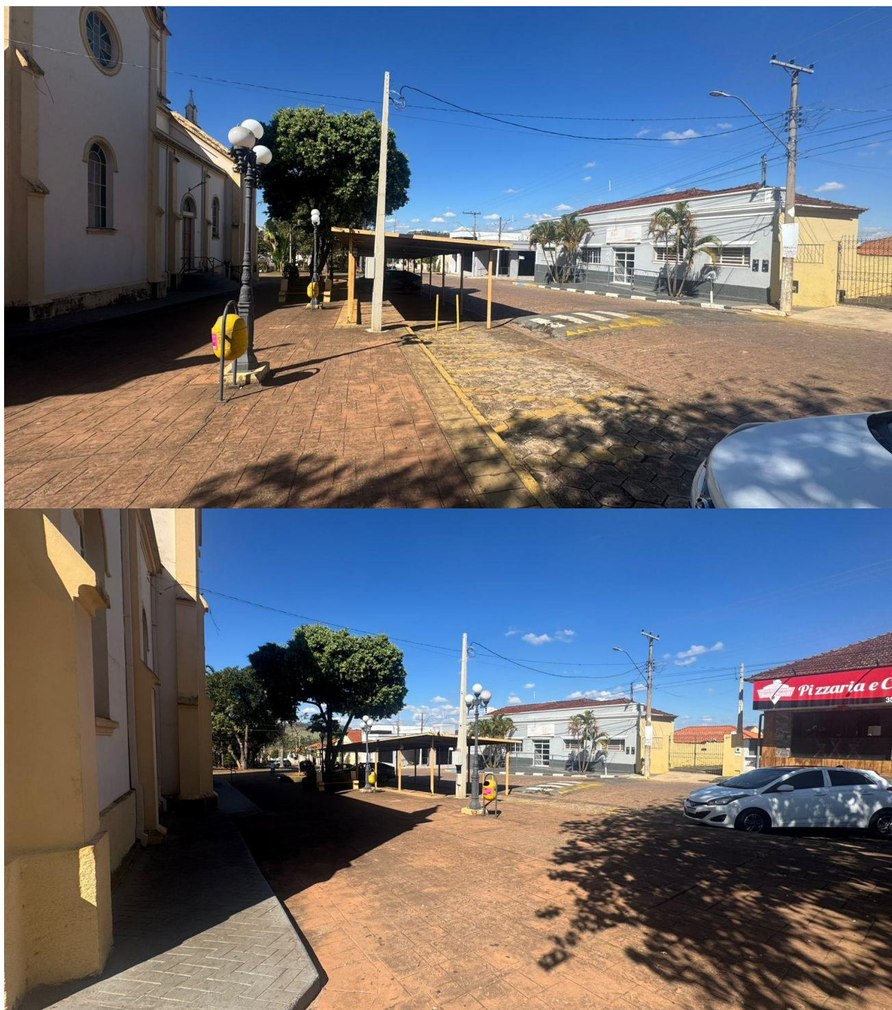
Figura 3 – Vista do ponto de táxi existente, evidenciando as condições atuais da estrutura e dos elementos de acabamento, com previsão de intervenção por meio de pintura.
