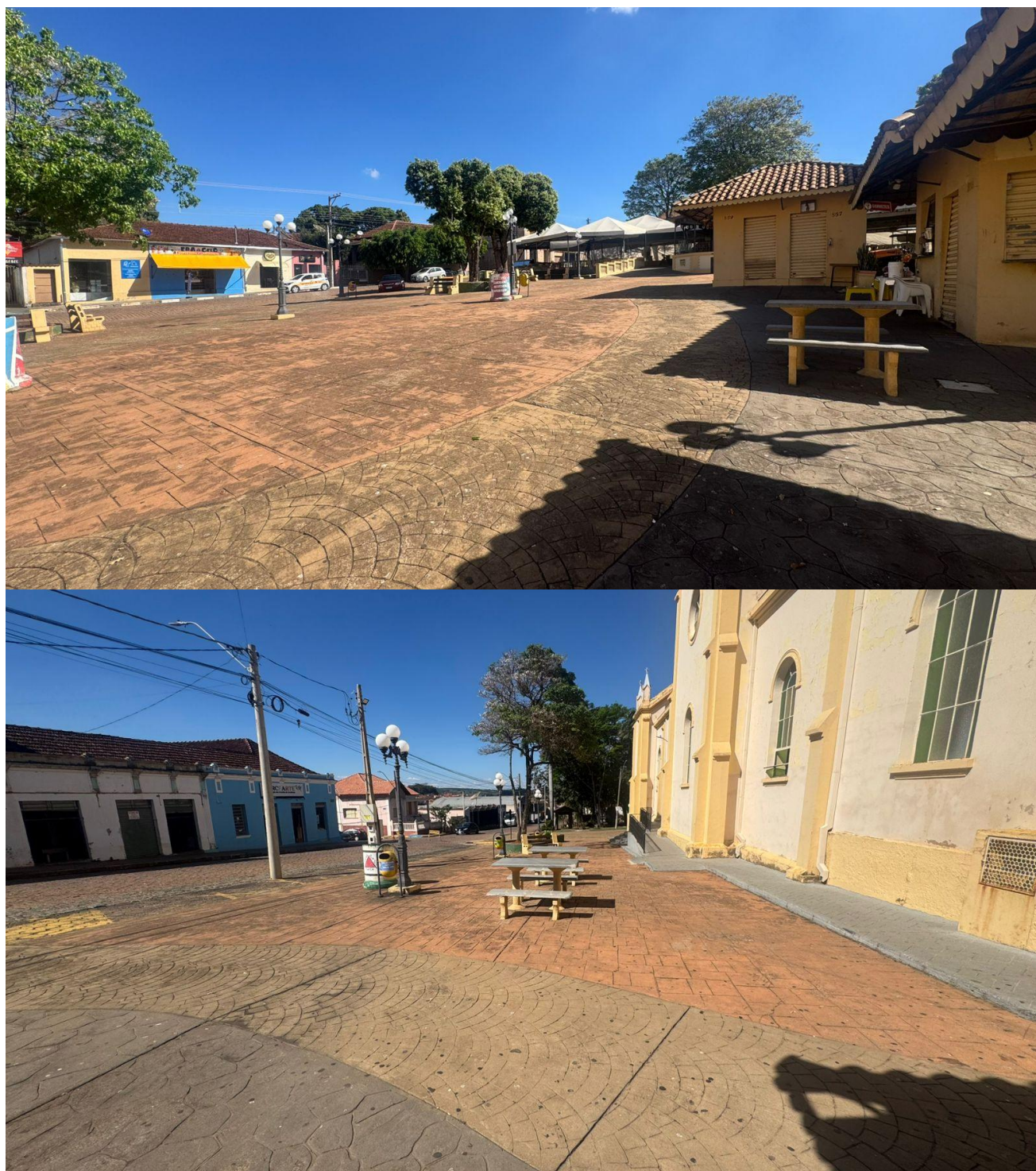
Figura 4 – Vistas do piso existente, registrando suas condições atuais e a área a ser contemplada com pintura, conforme previsto no projeto de revitalização.
