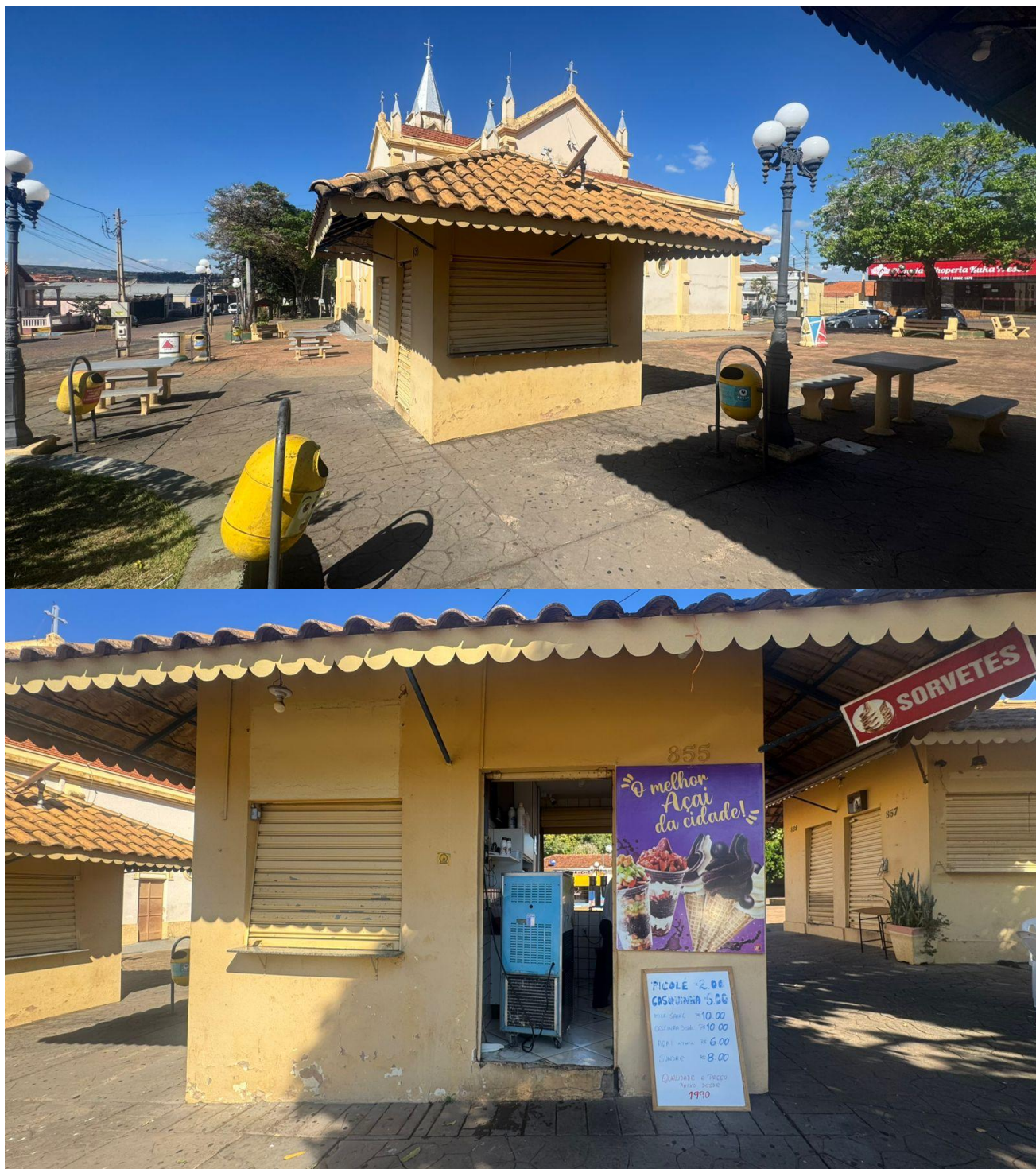
Figura 1 - Vistas do quiosque existente, evidenciando as condições atuais da edificação, cobertura, esquadrias e piso.
