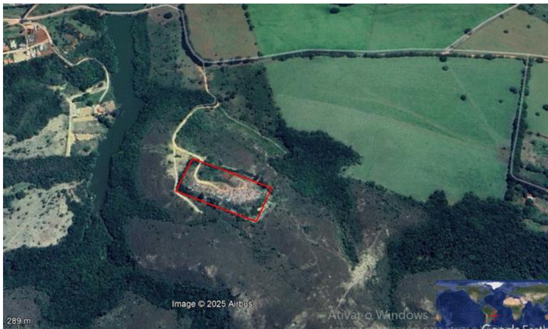
Figura 3. Área do aterro de RSU desativada
