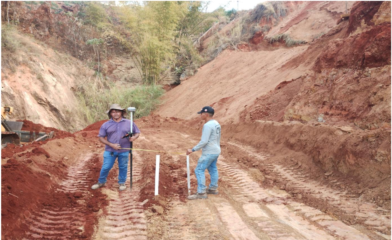
MARCAÇÃO TOPOGRÁFICA.
