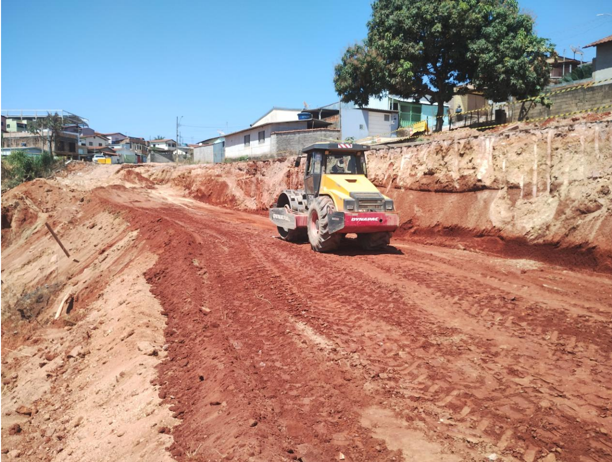
EXECUÇÃO COMPACTAÇÃO DE ATERRO.
