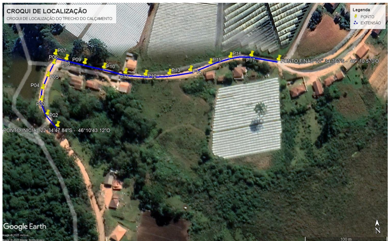
FOTO 1 – LOCAL DO CALÇAMENTO NA ESTRADA VICINAL SENTIDO AO BAIRRO CHAVEZADA - SENADOR AMARAL – MG.
