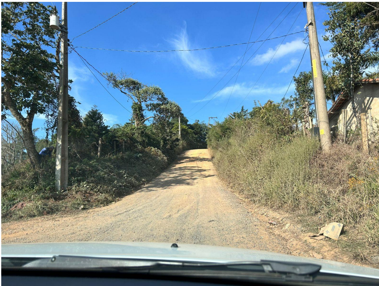
FOTO 2 – FOTO DO TRECHO DA ESTARADA VICINAL DO BAIRRO DA LAGOINHA SENADOR AMARAL – MG.
