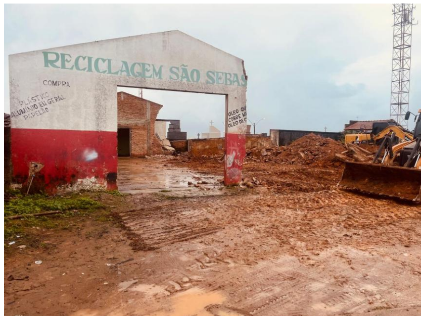
FOTO 02 – PREPARO DO TERRENO
