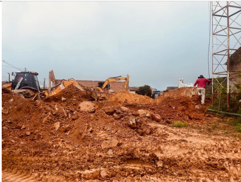
FOTO 01 – PREPARO DO TERRENO
