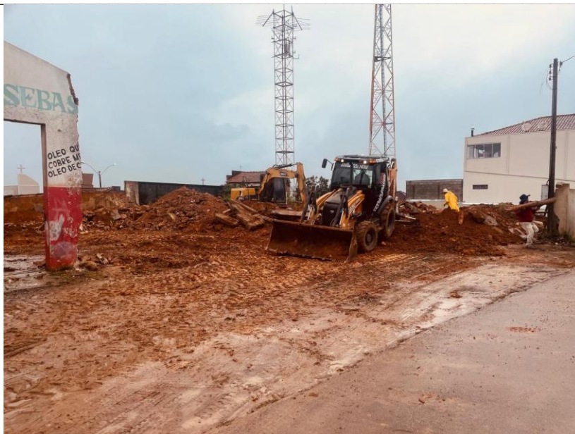
FOTO 03 – PREPARO DO TERRENO
