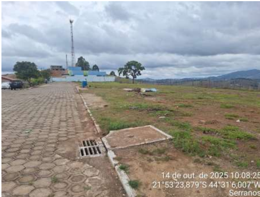
Foto 06 - Vista da rua Francisco Vilela Milward de Azevedo, com lotes – Quadra 01, ao lado direito da foto e detalhes de infraestrutura concluída: água, esgoto, drenagem pluvial, calçamento e passeios.
