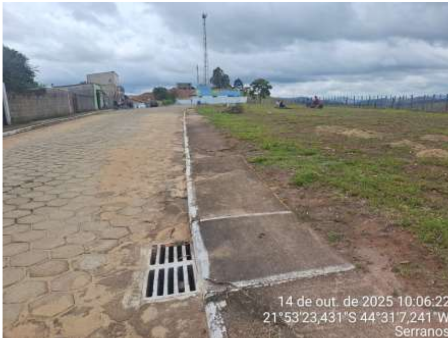
Foto 04 - Vista do interior dos lotes – Quadra 01 e para a rua Francisco Vilela Milward de Azevedo, ao lado esquerdo da foto, com detalhes de infraestrutura concluída: água, esgoto, drenagem pluvial, calçamento e passeios; com sentido da imagem para a UBS.
