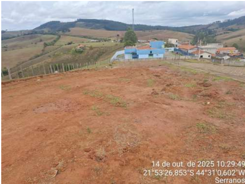
Foto 24 - Vista do interior dos lotes – Quadra 02, com sentido a torre.
