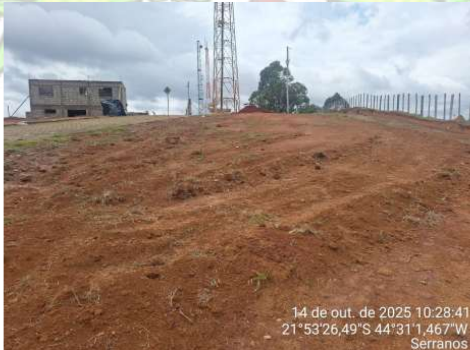
Foto 21 - Vista do interior dos lotes – Quadra 02, com sentido a torre.
