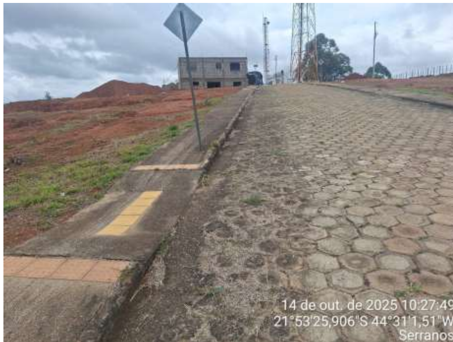
Foto 18 - Vista da rua rua projeta 2, com sentido para torre (fundos), com infraestrutura executada, com excessão da rede de energização e iluminação pública; e lotes – Quadra 02 à direita.
