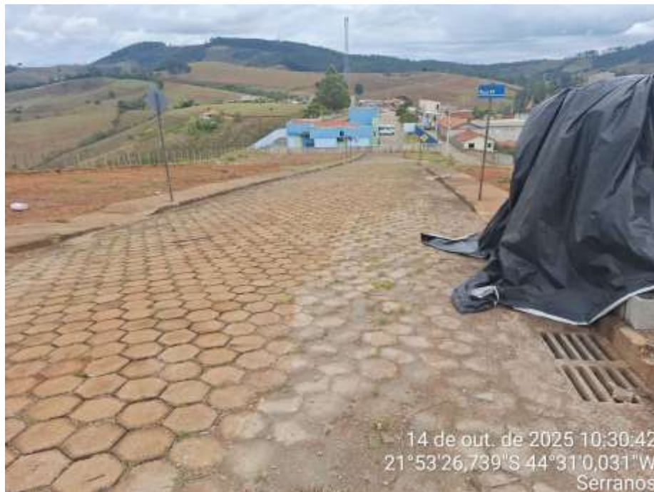
Foto 26 - Vista da rua projeta 2, com sentido para UBS, com infraestrutura executada, com excessão da rede de energização e iluminação pública; e lotes – Quadra 02 à esquerda.
