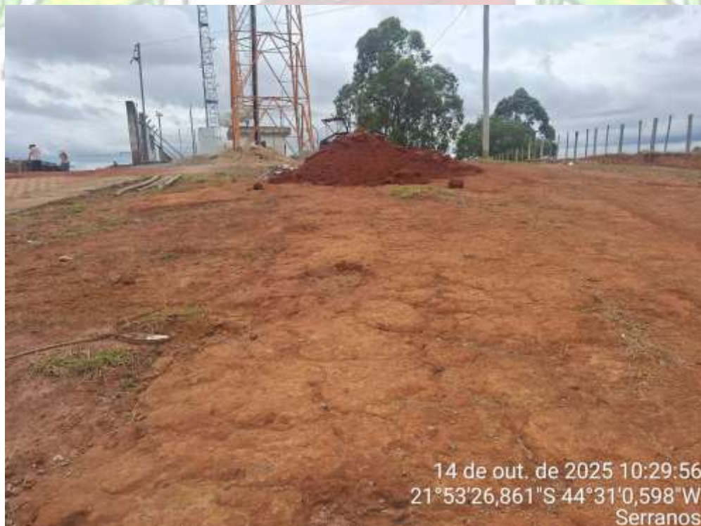
Foto 25 - Vista do interior dos lotes – Quadra 02, com sentido a torre.
