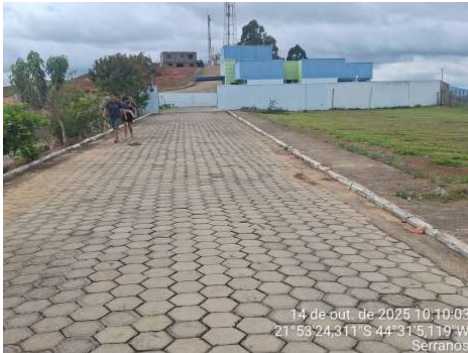
Foto 10 - Vista da rua Francisco Vilela Milward de Azevedo, com sentido UBS (fundos), com infraestrutura executada, com excessão da rede de energização e iluminação pública; e lotes – Quadra 01 à direita.
