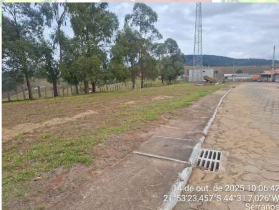
Foto 05 - Vista da rua Francisco Vilela Milward de Azevedo, com lotes – Quadra 01, ao lado esquerdo da foto e detalhes de infraestrutura concluída: água, esgoto, drenagem pluvial, calçamento e passeios.
