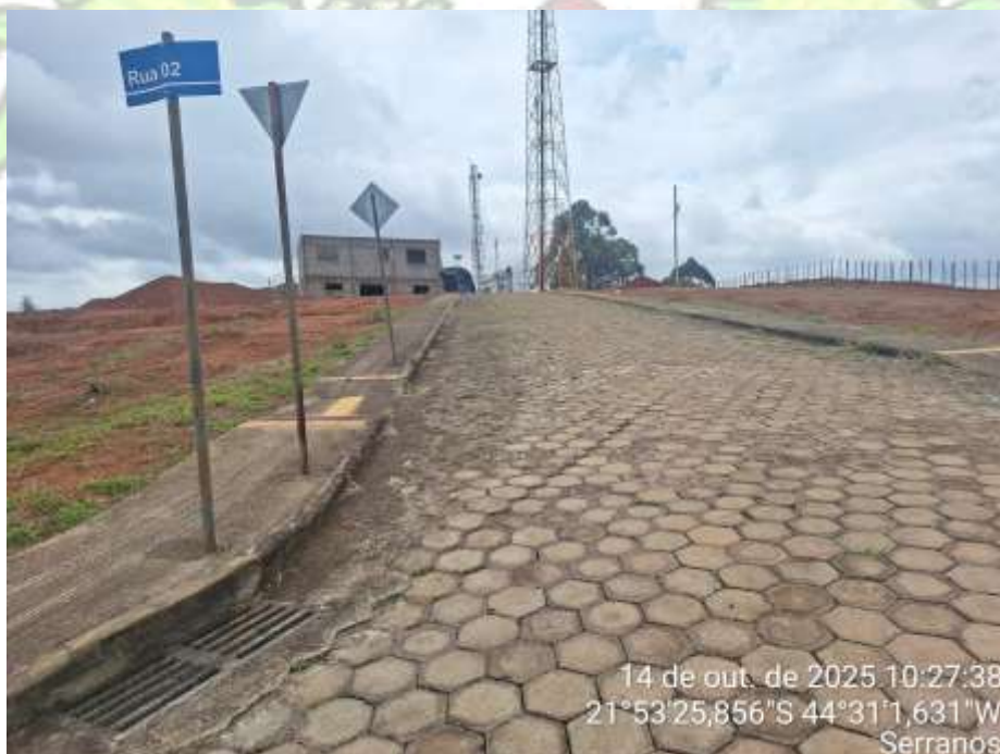
Foto 17 - Vista da rua rua projeta 2, com sentido para torre (fundos), com infraestrutura executada, com excessão da rede de energização e iluminação pública; e lotes – Quadra 02 à direita.
